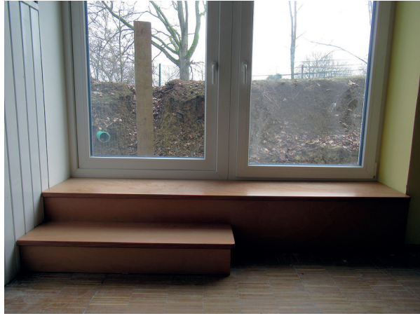
Notausstieg Bewegungsraum mit bodentiefem Fenster
