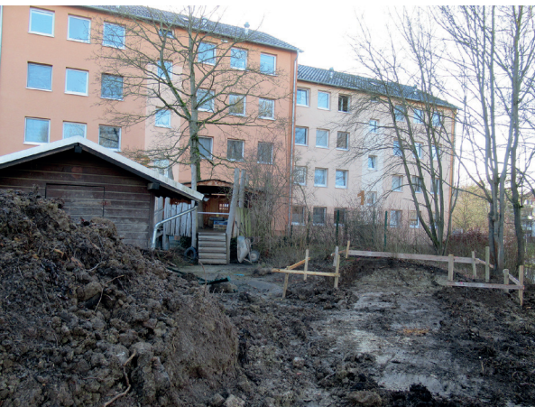
Freifläche für den Anbau
